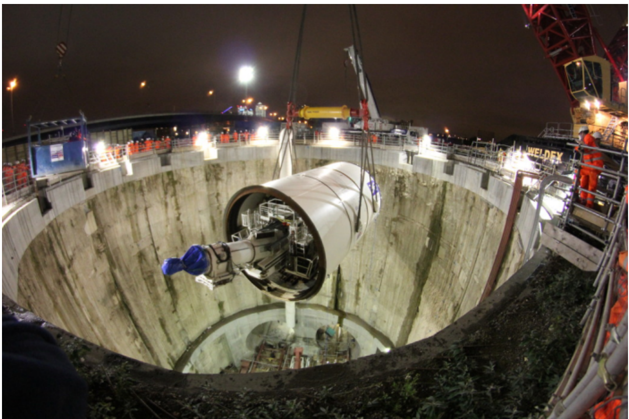
Một phần của máy khoan hầm cho tuyến tàu điện ngầm Elizabeth được hạ xuống nơi cần khoan.
